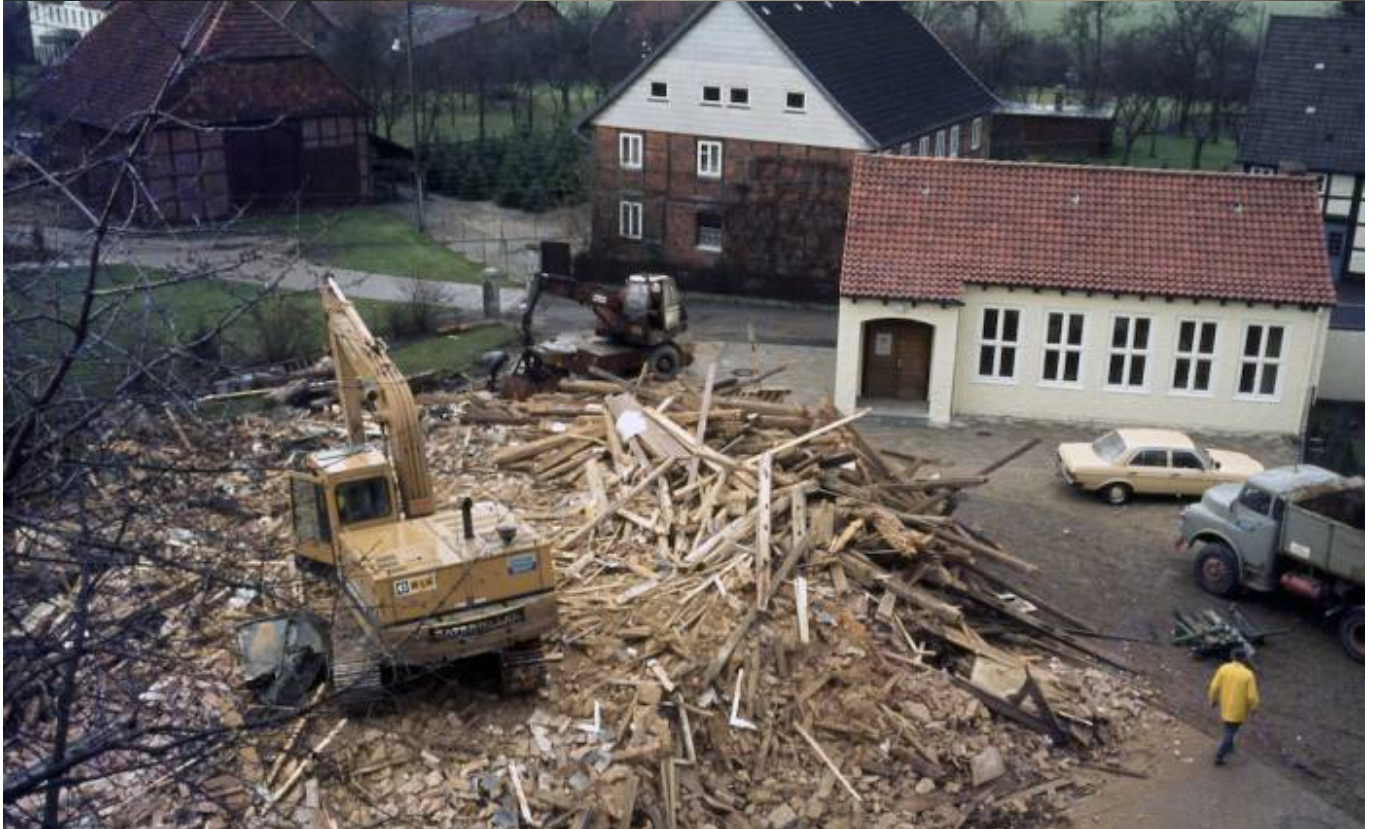
Am 13.3.1981 wurde das alte Lehrerhaus, das neben der Kirche 172 Jahre lang stand, abgerissen. Es enthielt von 1809 bis 1886 auch den Klassenraum.
