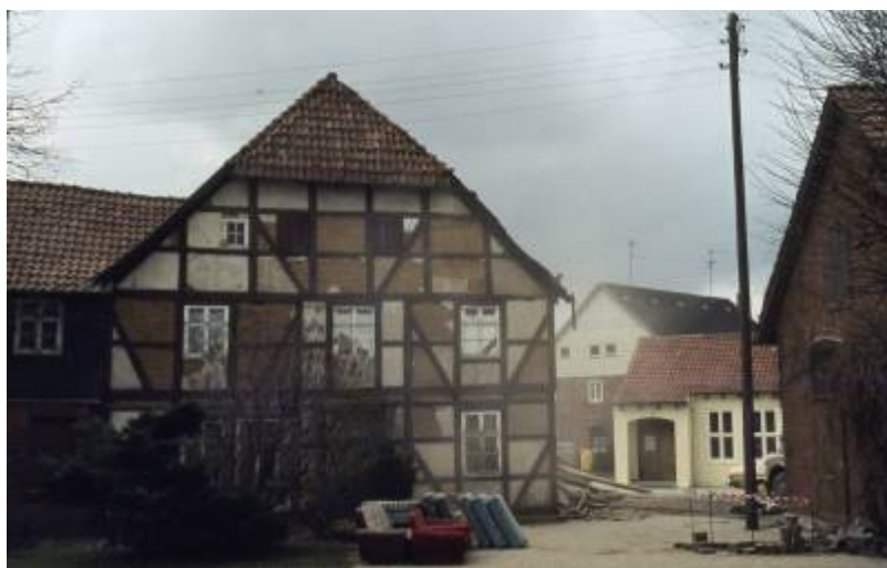
Vor der Nutzung das „Alten Schulhauses“ fand der Unterricht von 1809 - 1886 im Lehrerhaus statt. Aufnahme von 1981
